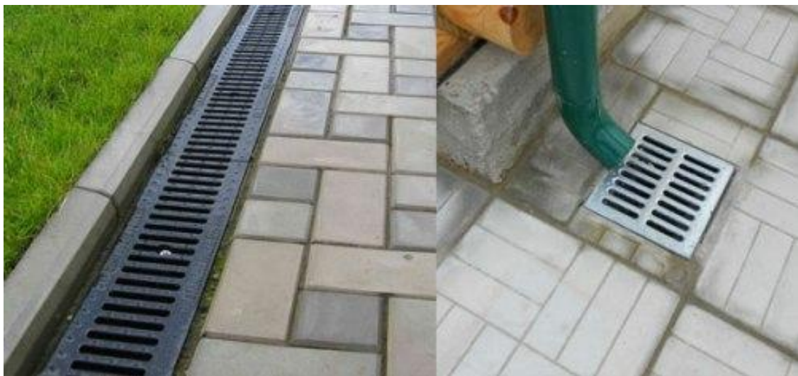
Рис.2. Устройство дождеприемников под водосточной трубой и вдоль бордюрного камня.
