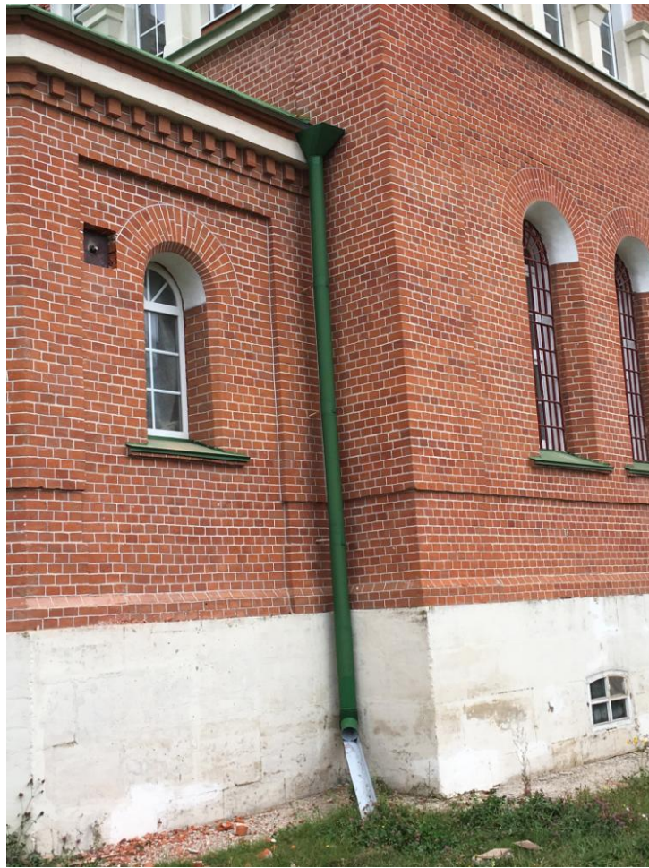
Фото 1. Сбор дождевой и талой воды с кровли с отводом воды на грунт
